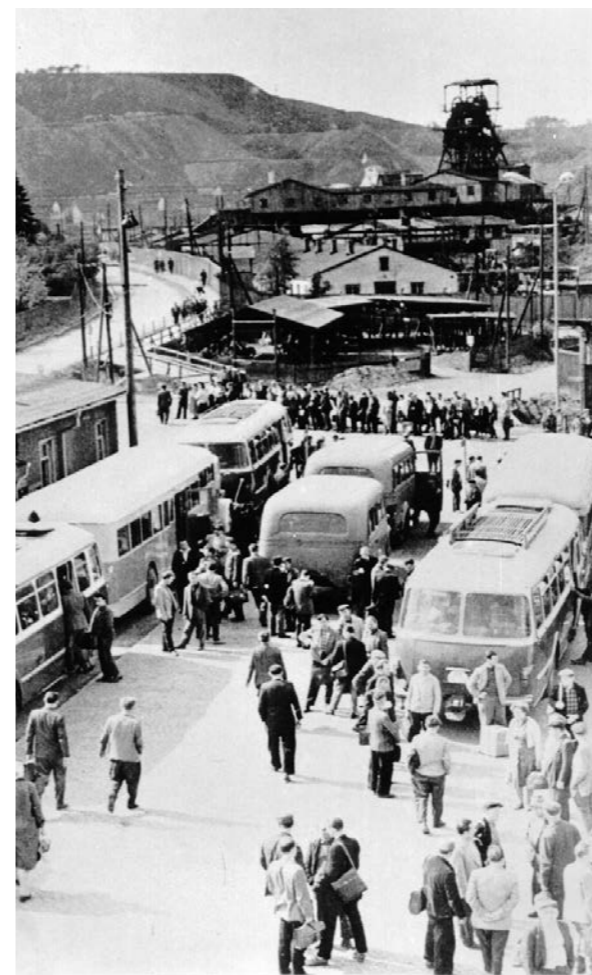
Der „Gummibahnhof“ in Schlema in der Nähe des Förderturms von Schacht 66 mit Abraumhalden im Hintergrund.
